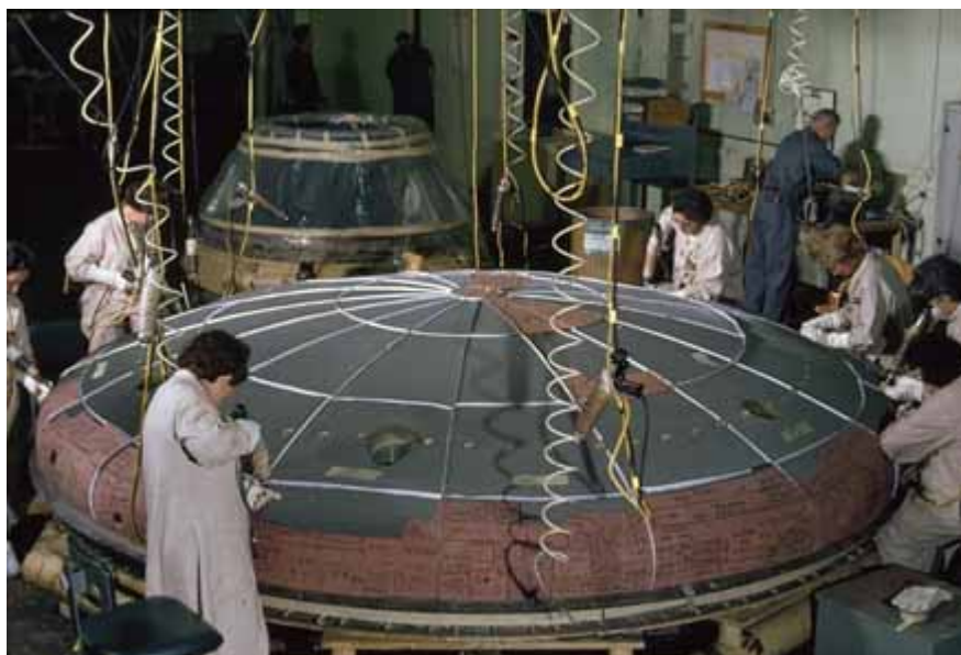
Figure 8 : Assemblage et isolation manuelle du bouclier thermique d'un vaisseau Apollo (Lowell)
