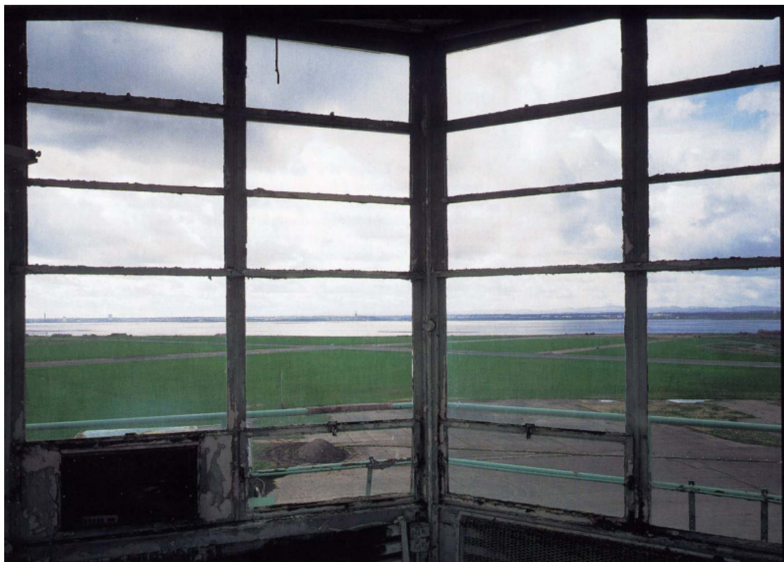
Fig. 24. Liverpool-Speke, vue sur le terrain depuis la tour de contrôle
