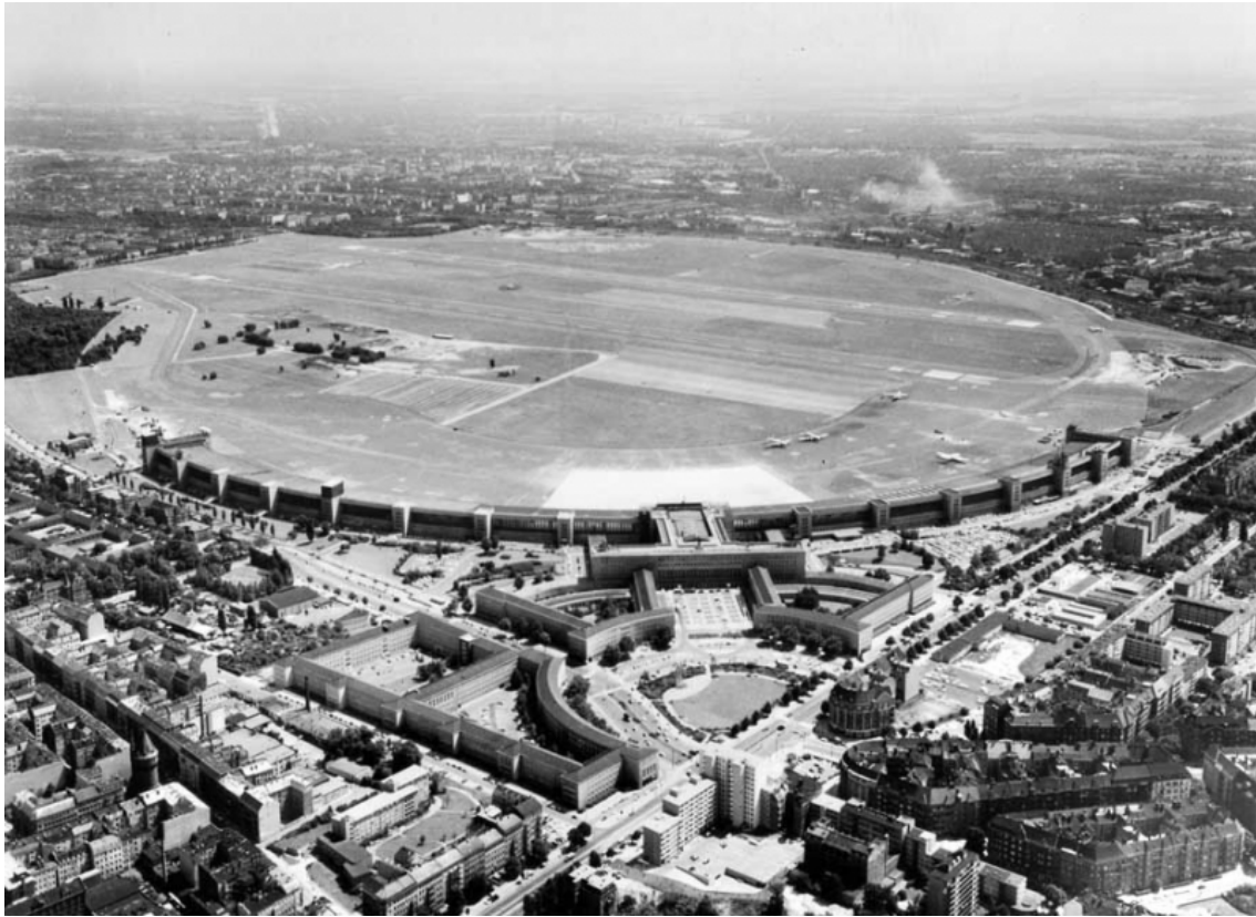
Fig. 14. Berlin-Tempelhof, vue d'ensemble de l'aéroport vers 1965
